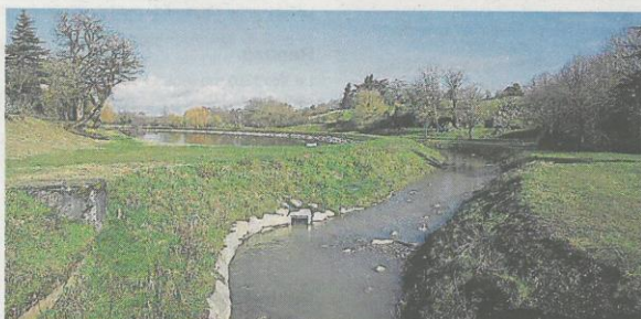
La Vaige traverse La Bazouge. Ses abords ont été aménagés pour que les habitants puissent en profiter.
