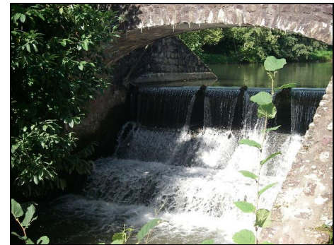
Ouvrage avant démantèlement
