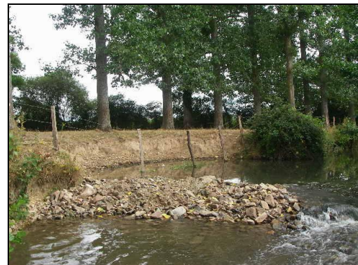
Seuil installé en 2010 par un agriculteur
