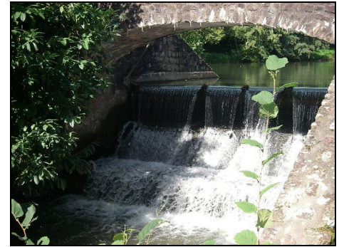
Ouvrage avant démantèlement
